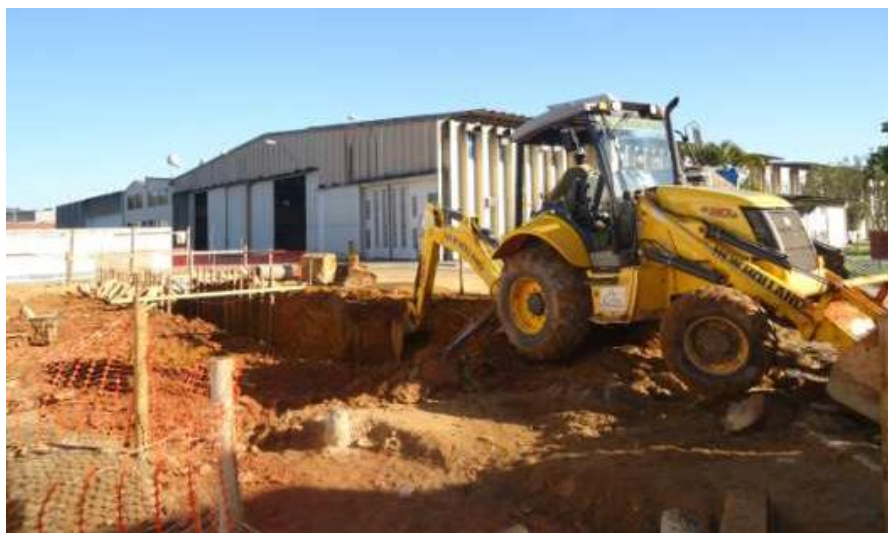
Vista geral do local da construção – escavação e escoramento
