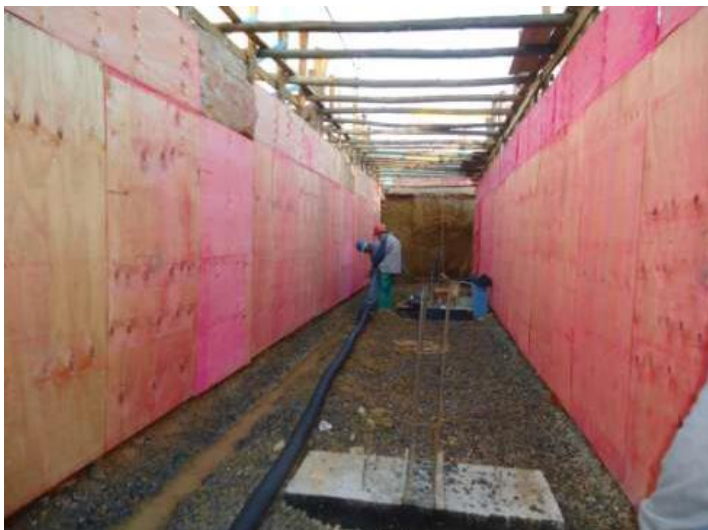
Fosso 1 – execução da camada de brita (blocos concretados e impermeabilizados)
