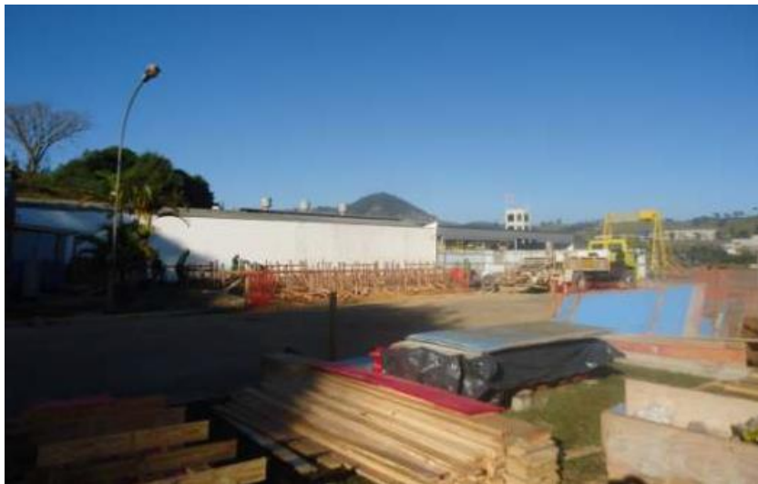
Vista geral do local da construção
