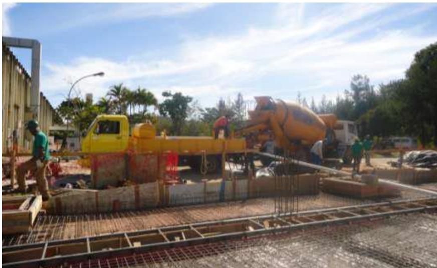
Visão geral da construção – área a ser concretada
