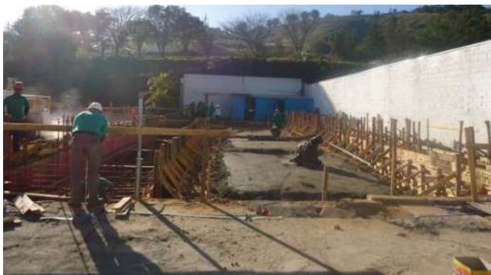
Visão geral da construção – fossos, concretagem e laje do piso
