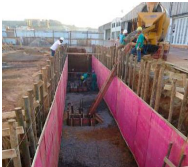
Concretagem dos blocos do fosso 2
