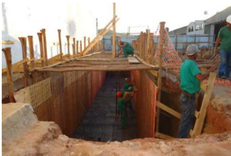
Execução das armaduras de parede e laje de fundo do fosso 1
