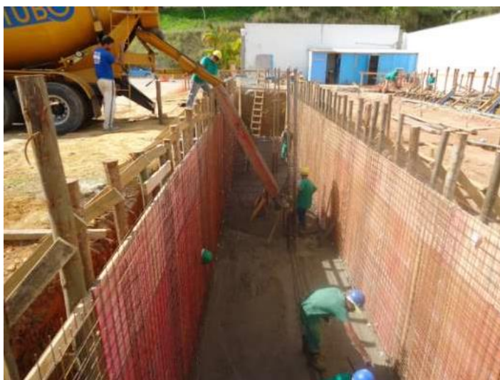
Concretagem da laje de fundo do fosso 2
