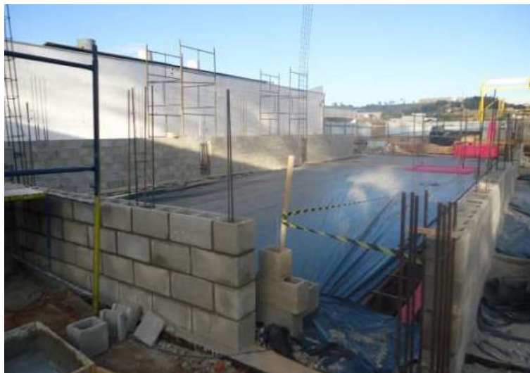
Visão geral da construção – levantamento da alvenaria estrutural
