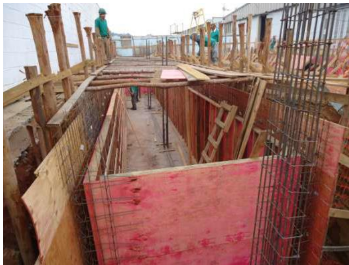
Execução das formas internas e das armaduras
