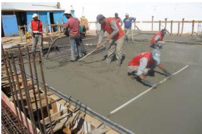
Concretagem da laje de piso
