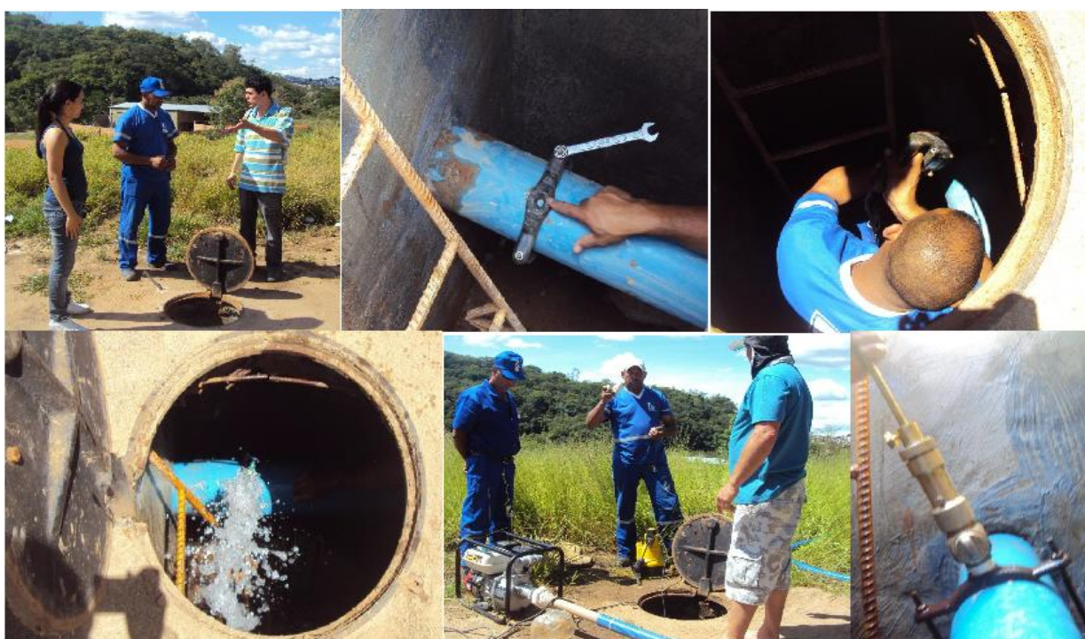
Figura 69 – Tubulação de entrada do sistema, adaptação e instalação do calibre.
