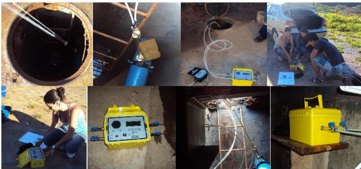
Figura 70 – Instalação, calibração, sangria (retirada do ar) e funcionamento.
