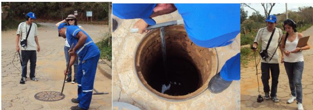
Figura 71 – Treinamento inicial junto ao profissional do SAAE na descarta da tubulação.
