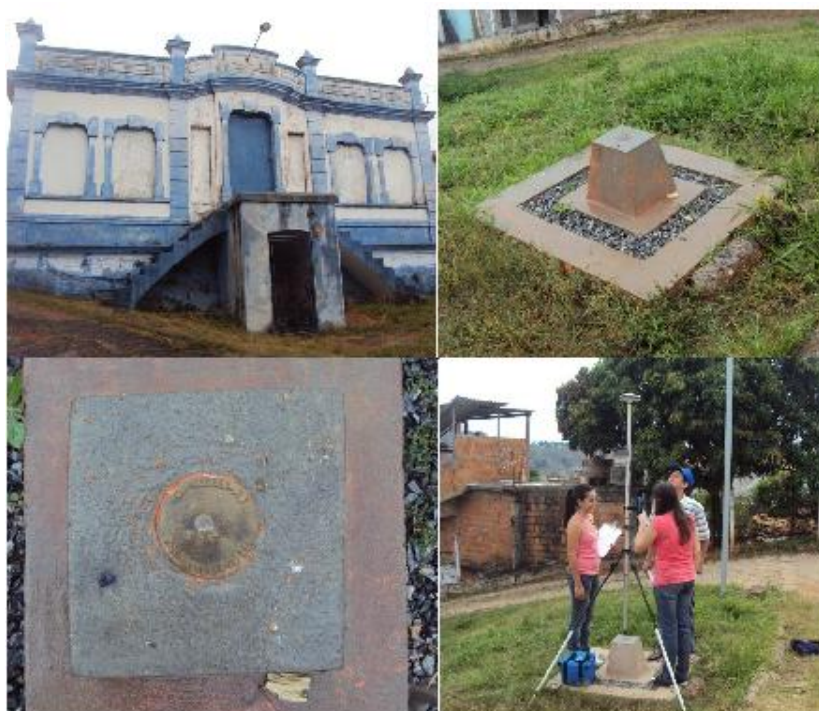
Figura 78 – ETA de Carmo de Minas, base cartográfica e instalação DGPS.
