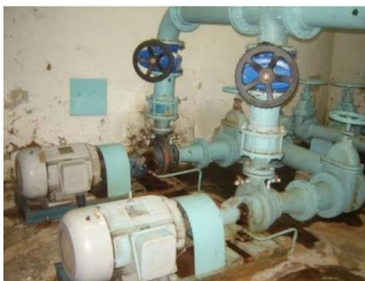
Figura 34 – Estação Elevatória Solar dos Lagos.
